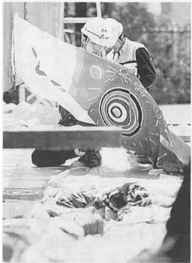
ヘルメット姿の作業員が状態を 確かめる
